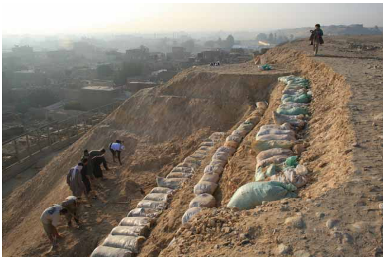
Илл. 9. Работы на Участке IV
