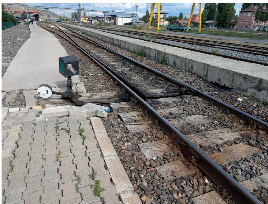
Рис. 5. Ручной стрелочный перевод и деревянные шпалы на ст. Карс в 2025 г. Фото автора
