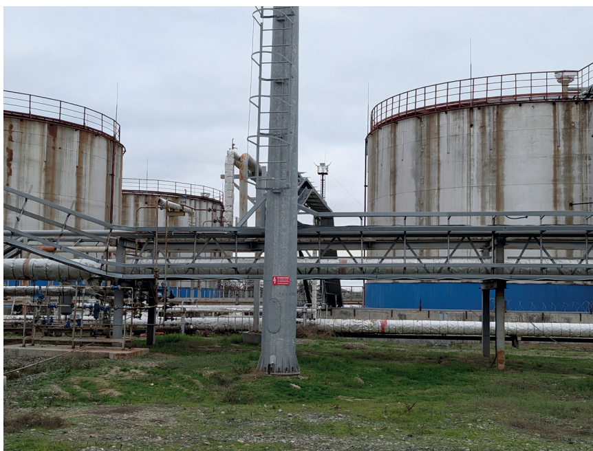
Рис. 4. Металлические резервуары, переделанные для хранения подсолнечного масла. Группа компаний «Ветин». Фото автора
